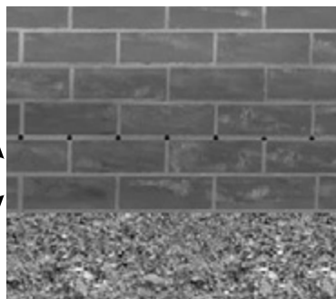
ukázka vyvrtání otvorů
