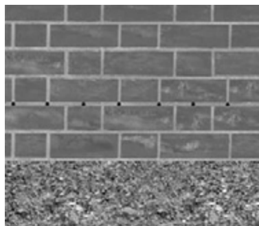
ukázka vyvrtání otvorů
