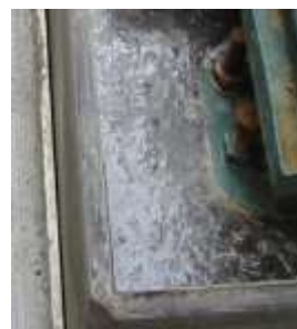
Po odstranění bednění jsou všechny hrany zkosené.
