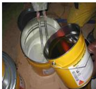
Míchání materiálu Sikafloor®-263 SL
