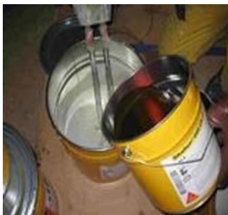
Míchání materiálu Sikafloor®-169
