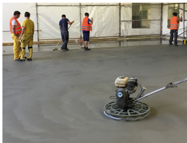
Aplikace penetrace ca 1,5 hod po finálním uhlazení (+20°C)
