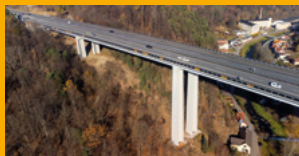
SANACE A OCHRANA KONSTRUKCÍ
