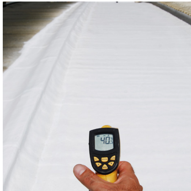
Povrchová teplota střechy po aplikaci.
