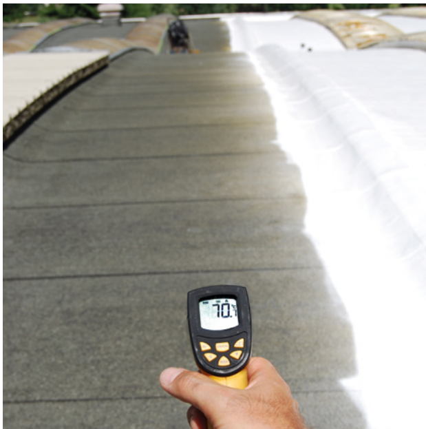
Povrchová teplota střechy před aplikací.
