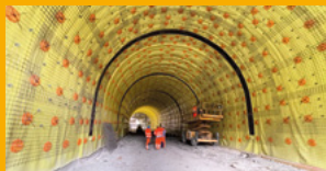
HYDROIZOLACE SPODNÍ STAVBY
