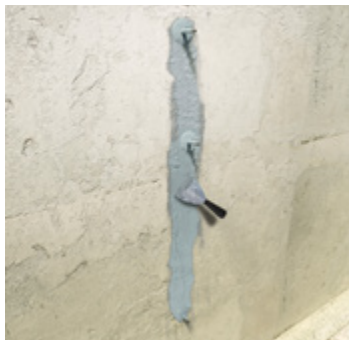
Těsnění trhlin
