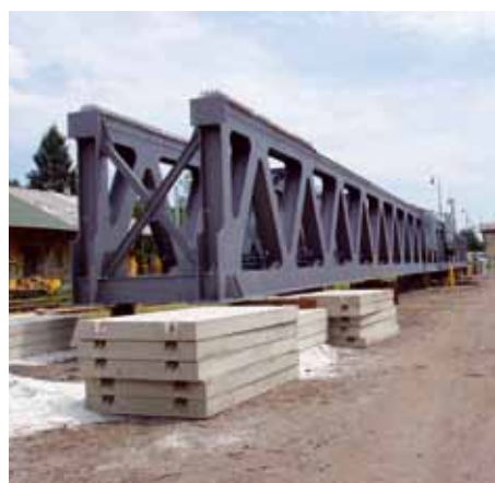
železniční most Klášterec nad Ohří
