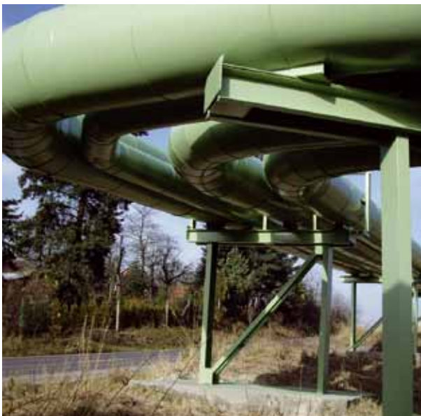
teplárna Písek ↑ silniční most Štěpán, přemostující řeku Labe u Neratovic →
