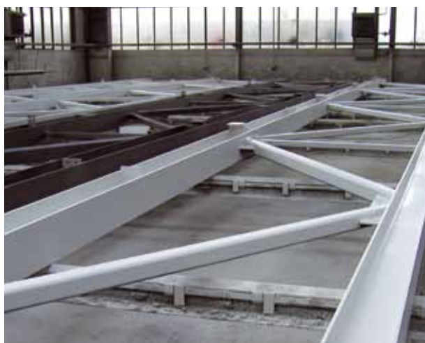
↑ oc. konstrukce hal, automobilka TPCA Czech, Kolín ← hraniční most na dálnici D8
