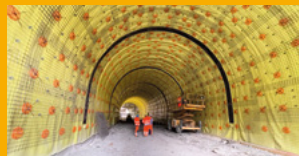
HYDROIZOLACE SPODNÍ STAVBY
