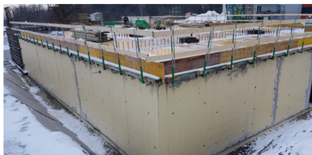
Zahloubené stěny izolované pomocí SikaProof® A+, po odstranění bednění musí být utěsněny otvory pro kotvy.
