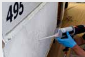
OPRAVA SENDVIČOVÉ- HO PANELU
