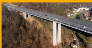
SANACE A OCHRANA KONSTRUKCÍ
