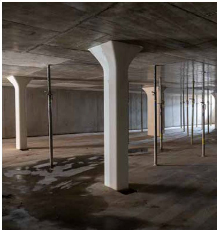
Instalováno na místě.
