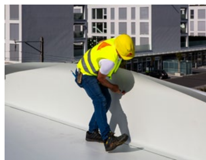
3. Přilepte samolepicí fólii.
