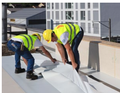
1. Odstraňte odnímatelnou fólii Sarnafil® AT FSA P.
