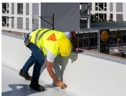
4. Zatlačte fólii do správné polohy vhodným válečkem.
