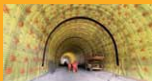
HYDROIZOLACE SPODNÍ STAVBY
