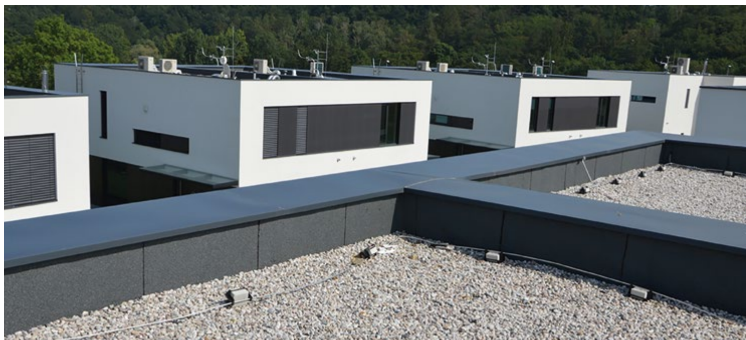
Ploché střechy s modifikovanými asfaltovými pásy Sika
