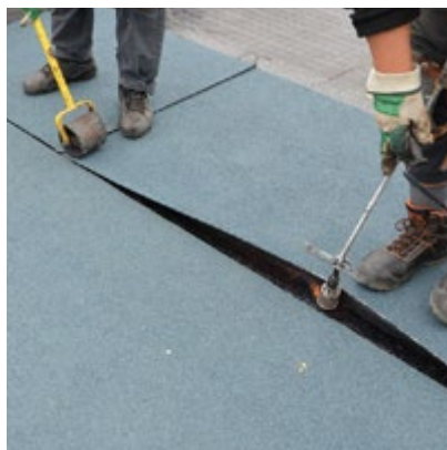
Natavování asfaltových pásů. (2. krok, podélný přesah)
