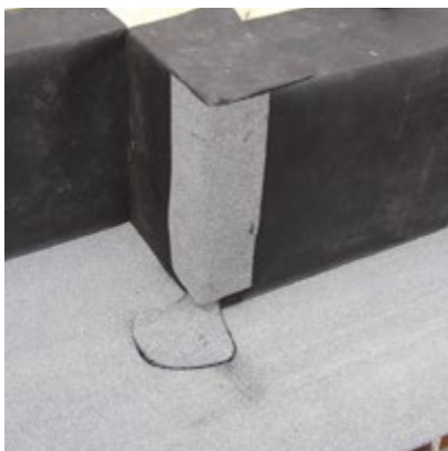
vyztužení vnější svislé hrany asfaltovým pásem „mineral“
