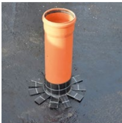
Opracování prostupu u hydroizolace spodní stavby.
