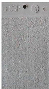
CSP-3: Lehce brokované
