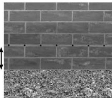
ukázka vyvrtání otvorů
