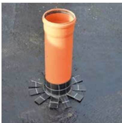
Opracování prostupu u hydroizolace spodní stavby.
