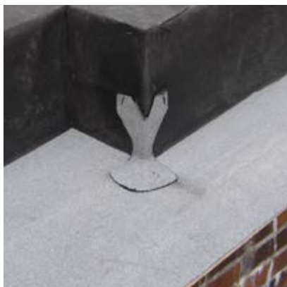
vodorovná plocha spodní asfaltový pás „mineral“ a vyztužení vnějšího rohu
