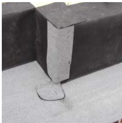
vyztužení vnější svislé hrany asfaltovým pásem „mineral“
