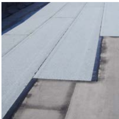
Montáž asfaltových pásů s vystřídáním spoji.
