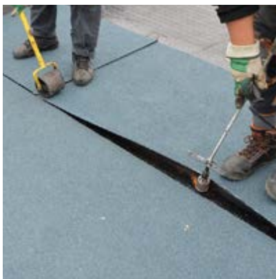
Natavování asfaltových pásů. (2. krok, podélný přesah)
