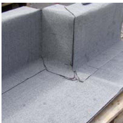
vnější roh i vnitřní kout jsou opracovány spodními asfaltovými pásy „mineral“
