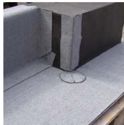
svislá plocha se zajištěním vnitřního koutu
