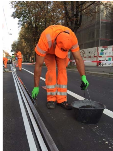
Obrázek 3: Prosypání povrchu tmelu Sikaflex®-406 KC křemičitým pískem
