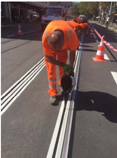
Obrázek 2: Aplikace tmelu Sikaflex®-406 KC přímo z nádoby
