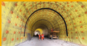
HYDROIZOLACE SPODNÍ STAVBY
