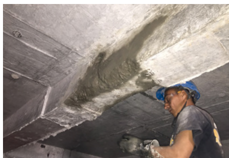
Opravy a renovace betonu, Strana 28
