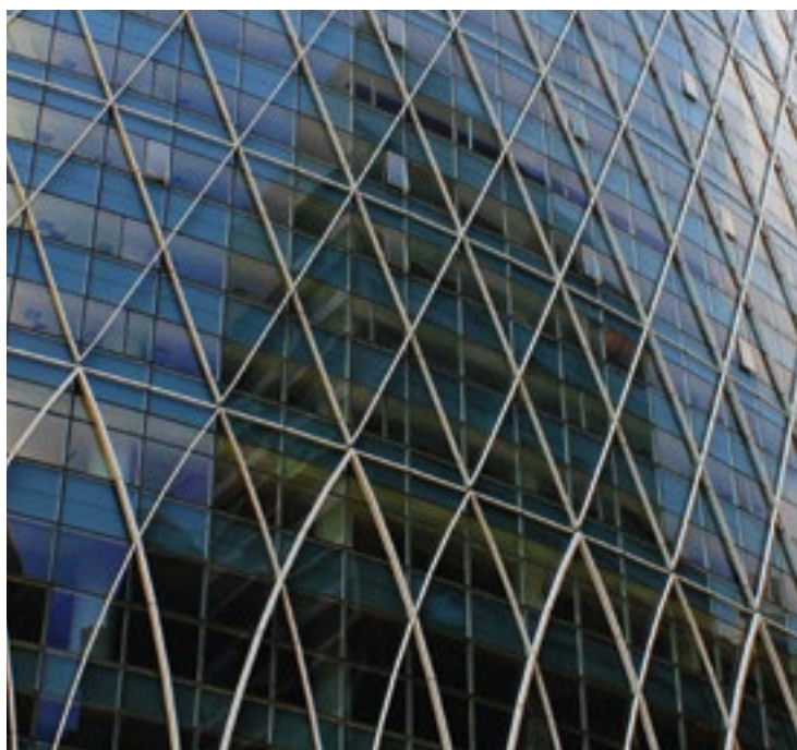
Menara Bank Islam (Menara Wakaf), Kuala Lumpur, 2001 Architekti RSP Architects / Fasáda Puspajaya Aluminium
