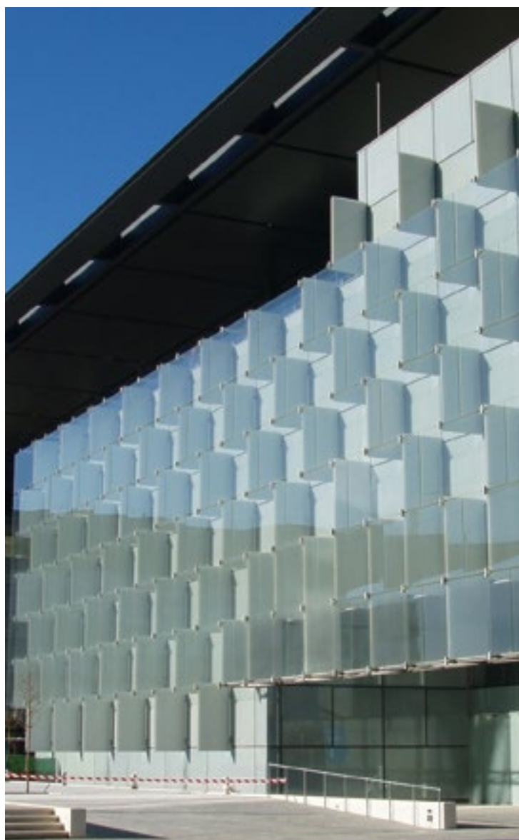
Sídlo společnosti Telefónica, Madrid, 2006 Architekti Rafael de la Hoz
