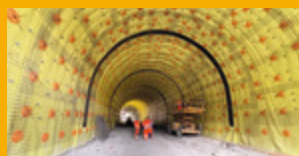
HYDROIZOLACE SPODNÍ STAVBY
