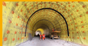
HYDROIZOLACE SPODNÍ STAVBY
