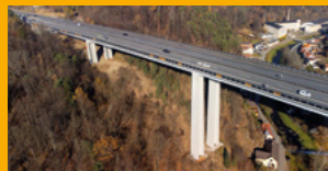
SANACE A OCHRANA KONSTRUKCÍ
