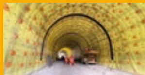
HYDROIZOLACE SPODNÍ STAVBY
