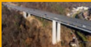
SANACE A OCHRANA KONSTRUKCÍ
