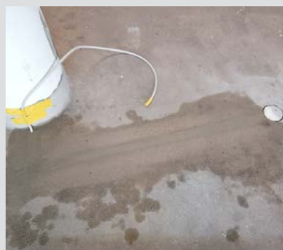
Obrázek 6. Instalace multisnímačů DuraMon do stávajícího betonu pomocí betonových jader vybavených snímačovým systémem DuraMon
