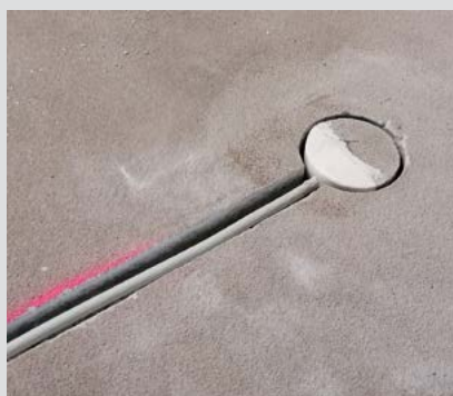
Obrázek 6. Instalace multisnímačů DuraMon do stávajícího betonu pomocí betonových jader vybavených snímačovým systémem DuraMon
