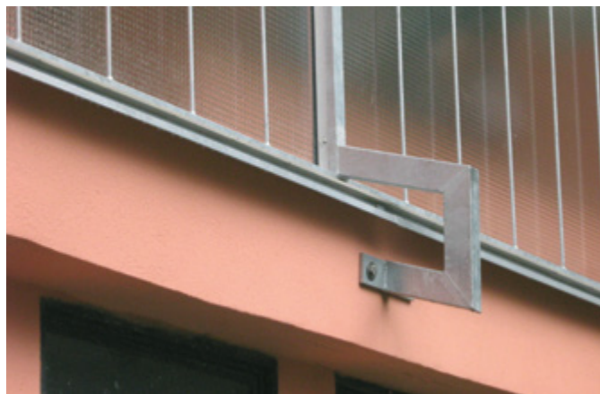
kotvení zábradlí do čela balkónu
