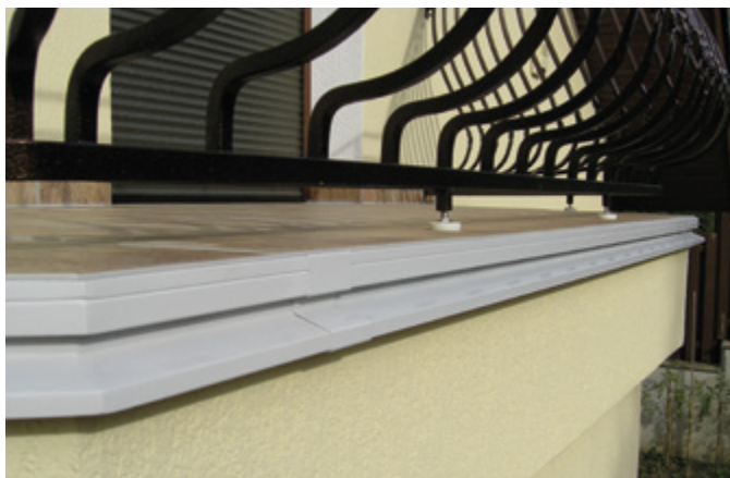
kotvení zábradlí do stěn s opřením o dlažbu
