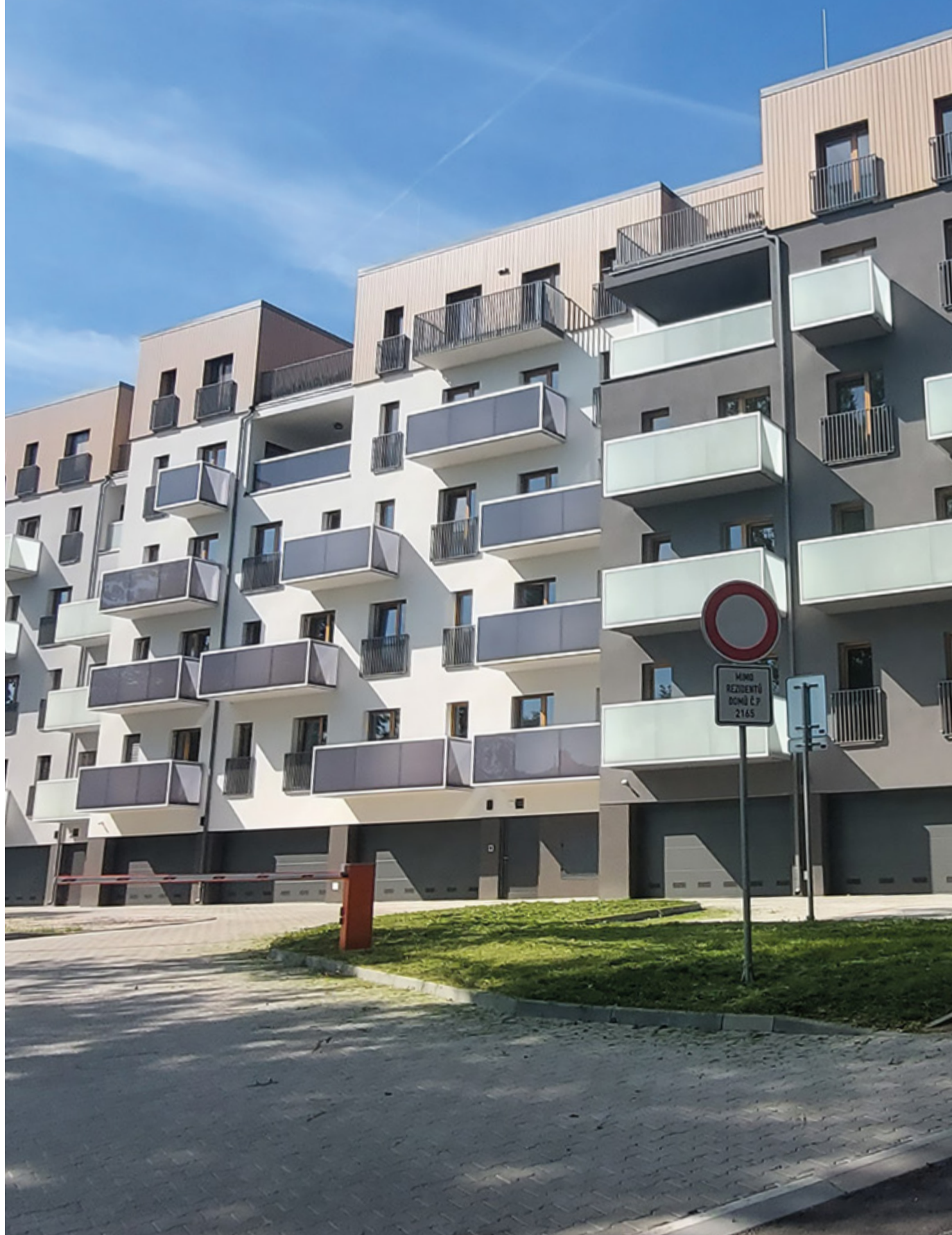
Naše reference – Rezidence Keltičkova, Ostrava Balkónový systém PCI Pecitherm® Klasik Foto: Ing. Lukáš Žachar
