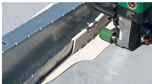
Svařování přírubového spoje SikaRoof® Click horkým vzduchem pomocí poloautomatického svařovacího stroje.
