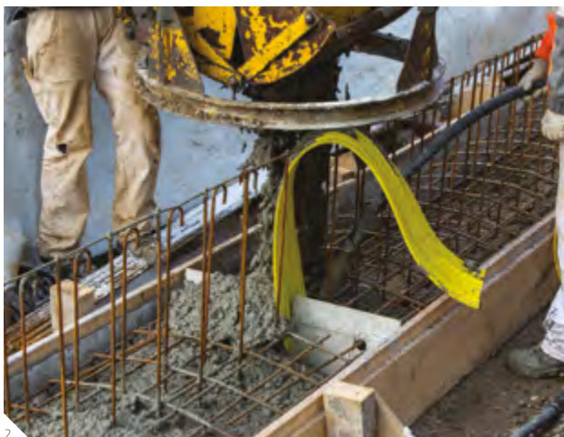
2 Bílá vana (z vodonepropustného betonu s přísadami Sika)
