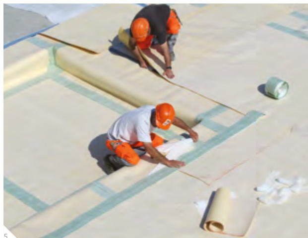
5 Celoplošně přilnutý hydroizolační systém
