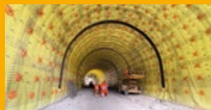
HYDROIZOLACE SPODNÍ STAVBY
