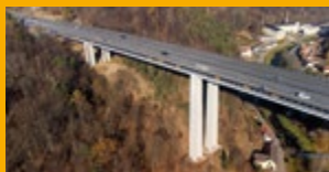
SANACE A OCHRANA KONSTRUKCÍ
