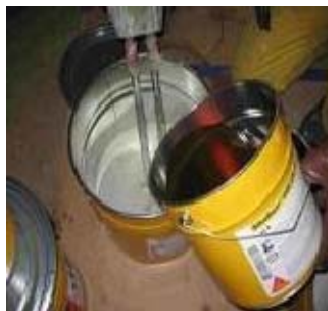
Míchání materiálu Sikafloor®-169
