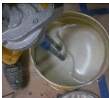
Míchání materiálu Sikafloor®-169 a Sika®-CompactFiller
