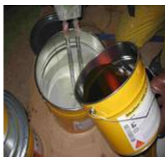
Míchání materiálu Sikafloor®-169
