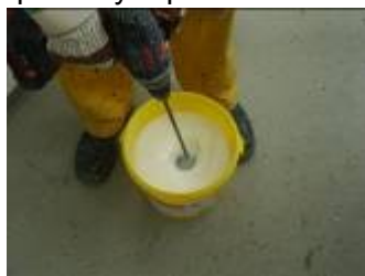
Míchání materiálu Sikafloor®-304 W
