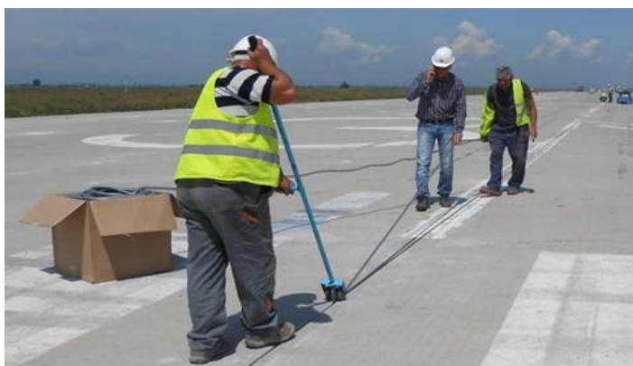
Obrázek 1: Aplikace výplňového provazce válečkem
