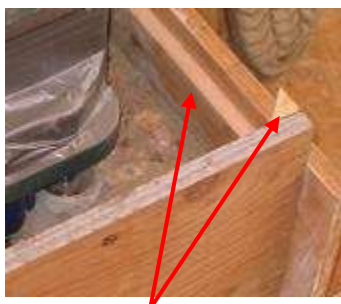
Dřevěné trojúhelníkové lamely, které jsou instalovány v bednění.
