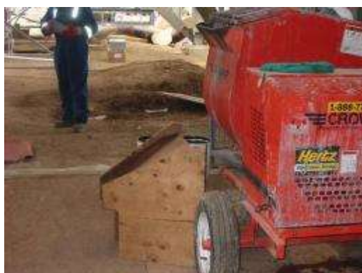
Zásobník pro namíchaný materiál v přední části míchacího zařízení
