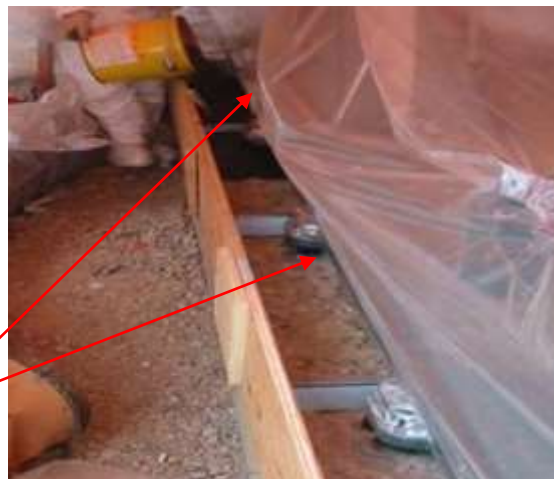
Předem instalované dilatační/řízené spáry
