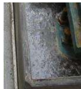
Po odstranění bednění jsou všechny hrany zkosené.
