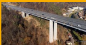
SANACE A OCHRANA KONSTRUKCÍ
