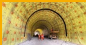
HYDROIZOLACE SPODNÍ STAVBY
