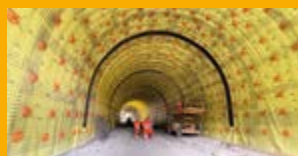
HYDROIZOLACE SPODNÍ STAVBY
