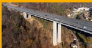
SANACE A OCHRANA KONSTRUKCÍ
