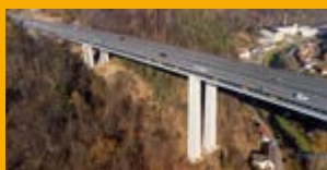
SANACE A OCHRANA KONSTRUKCÍ
