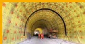
HYDROIZOLACE SPODNÍ STAVBY
