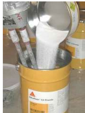
Jakmile jsou jednotlivé složky dostatečně smíchány, přidejte tvrdidlo ve správném množství.
