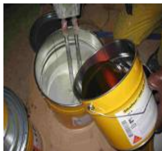
Míchání materiálu Sikafloor®-169
