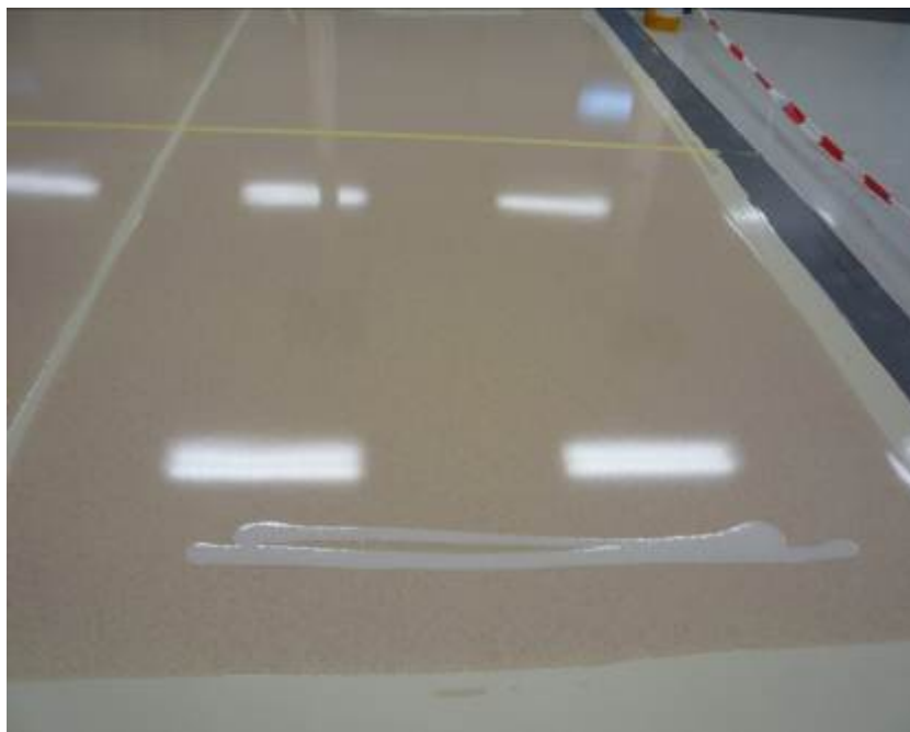
Sikafloor®-169 "Thixo" nalitý na podlahu
