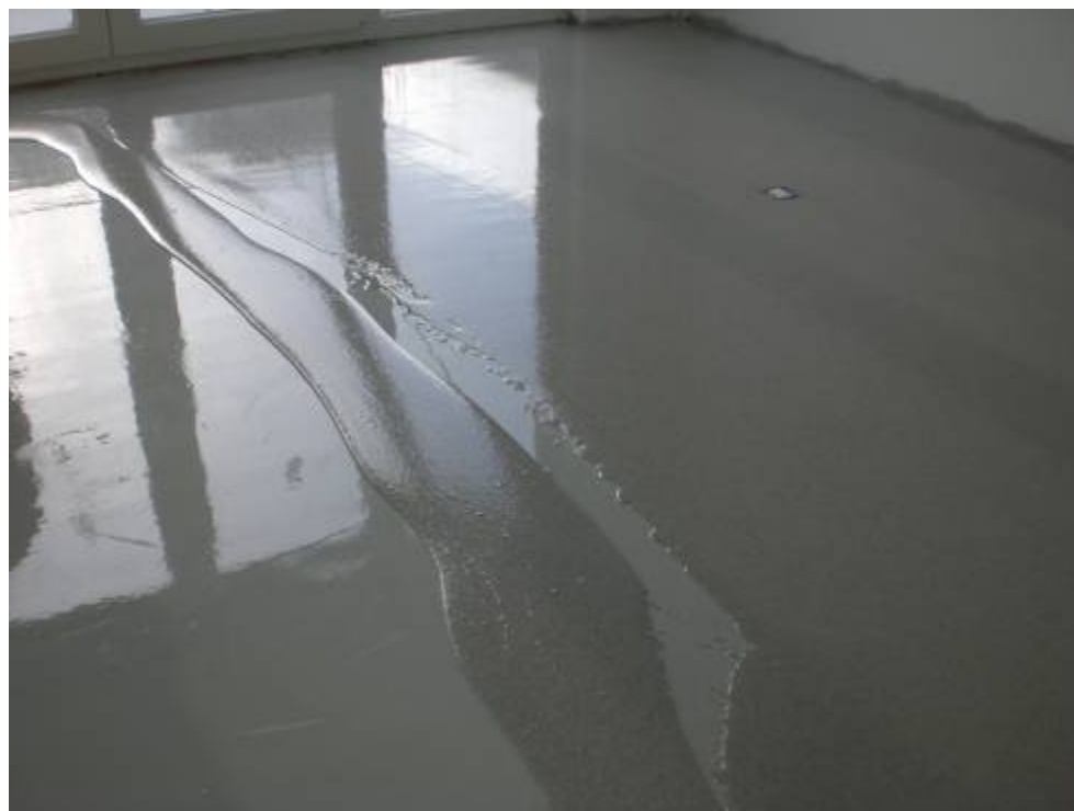
Aplikace materiálu zubovou stěrkou PPW 48
