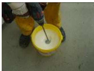
Míchání materiálu Sikafloor®-304 W
