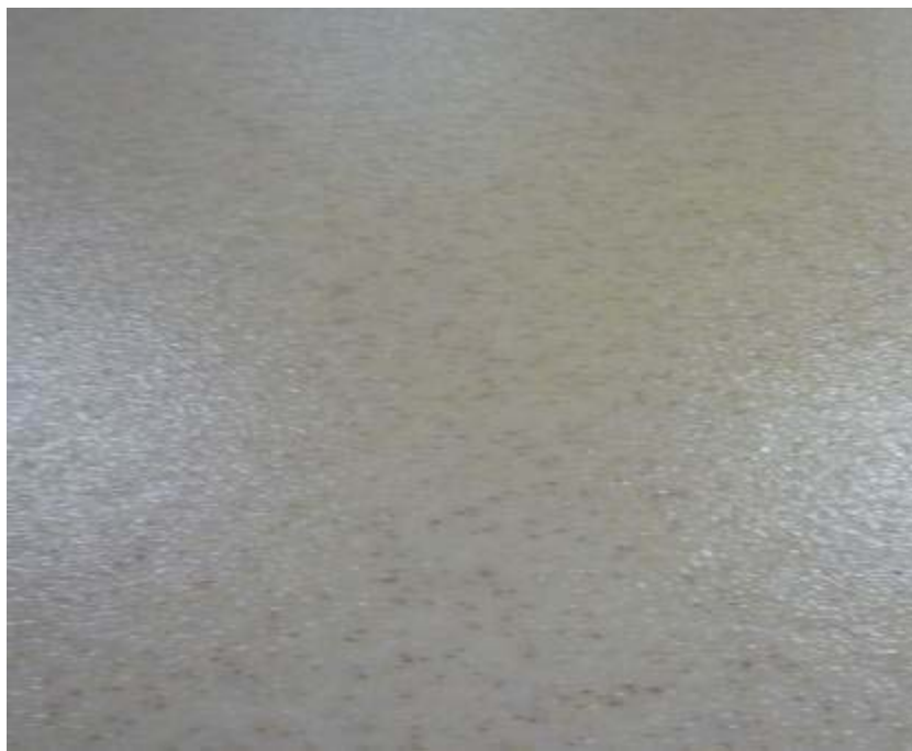
Detailní pohled na hotovou podlahu
