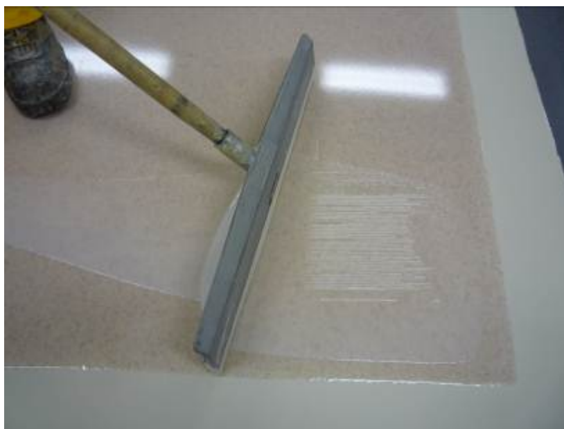
Sikafloor®-169 "Thixo" rovnoměrně rozestíraný gumovou stěrkou se zoubkovaným okrajem.
