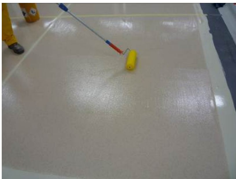
Sikafloor®-169 "Thixo" zaválený v příčném směru strukturovacím válečkem
