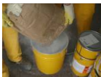
Smíchání materiálu Sikafloor®-169 a plniva Sikafloor®-DecoFiller
