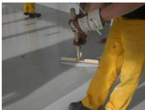
Aplikace materiálu zubovou stěrkou PPW 48
