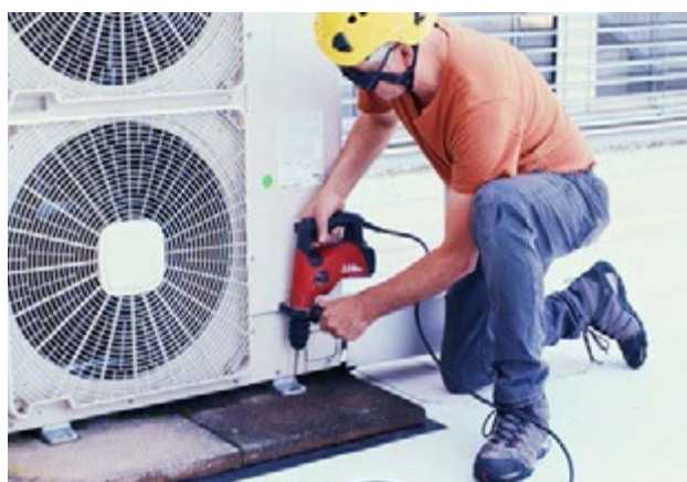
Vrtání otvorů do střešní hydroizolační fólie při instalaci různých zařízení po dokončení aplikace.
