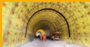
HYDROIZOLACE SPODNÍ STAVBY
