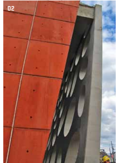
02 > Vstupní stěna po dokončení
