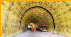
HYDROIZOLACE SPODNÍ STAVBY
