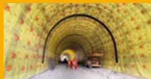
HYDROIZOLACE SPODNÍ STAVBY
