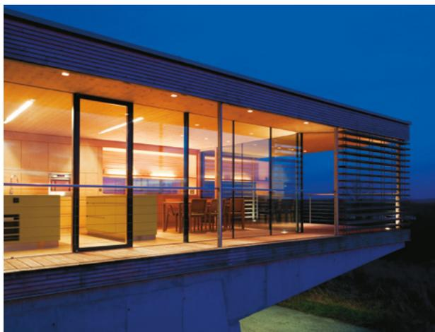
Okna s rámy ve tvaru L dosahují optimálního faktoru rámu díky tomu, že izolační sklo je zcela podepřeno lepidlem. Architekti oceňují výsledný celoprosklený exteriér, zatímco vynikající tepelná a zvuková izolace ve spojení s nízkým poměrem rámu ke sklu je přesvědčivým argumentem pro celý projekční tým. Stejně tak jsou majitelé nadšeni dlouhou životností a minimálními nároky na údržbu konstrukčně lepených oken. Společnost Sika vám poskytne podrobné informace o strukturálně lepených oknech.
