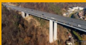
SANACE A OCHRANA KONSTRUKCÍ
