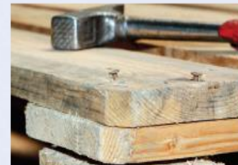
Zatlučení vyčnívajících spojovacích prvků
