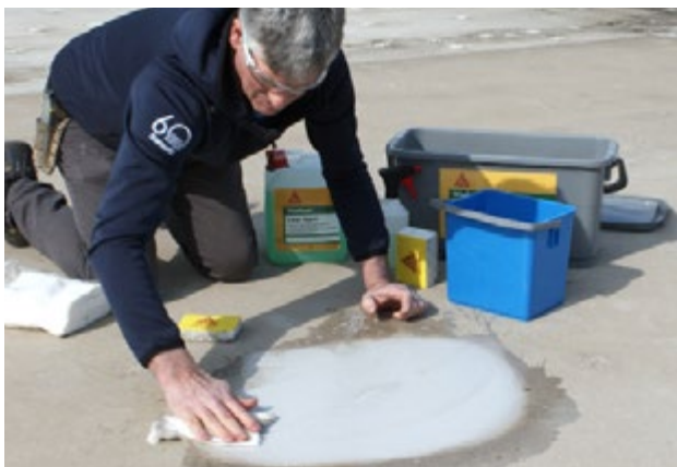
5. Čištění opravované plochy (jak bylo popsáno v kapitole čištění).
