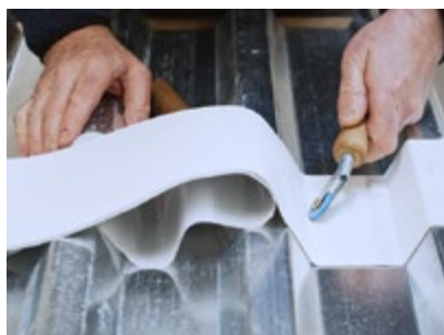
Výrobek přilne k široké škále podkladů a je schopen se přizpůsobit složitým tvarům konstrukce.
