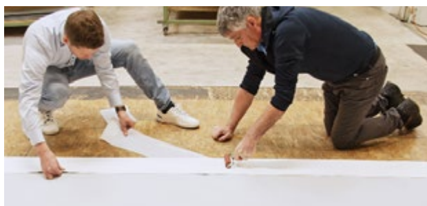
1. Instalace pásky SikaRoof® Multitape na horní povrch existující syntetické nebo asfaltové hydroizolace.
