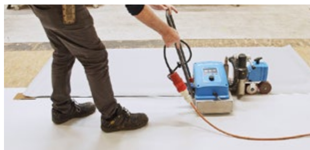
4. Automatické horkovzdušné navaření FPO Sarnafil® fólie na pásku SikaRoof® Multitape.
