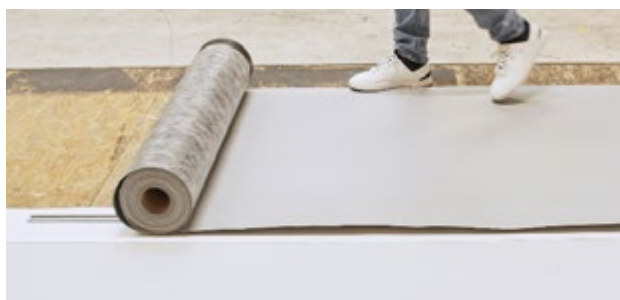
3. Rozvinutí nové FPO Sarnafil® hydroizolační fólie.
