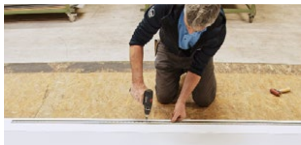
2. Instalace kotvicí lišty Sarnabar® pomocí kotvicích prvků Sarnafast® Fasteners a svařovacího drátu Sarnafil® T Welding Cord.
