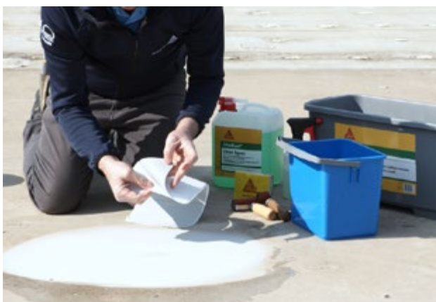
7. Odstranění Finger-lif ochranné fólie.
