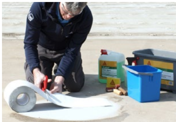
6. Příprava pásky SikaRoof® Multitape potřebné délky.
