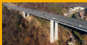
SANACE A OCHRANA KONSTRUKCÍ
