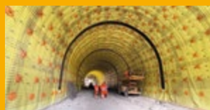
HYDROIZOLACE SPODNÍ STAVBY
