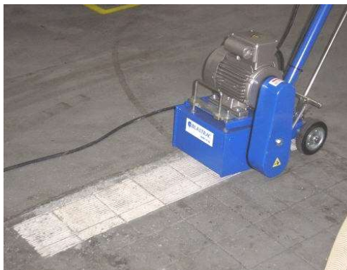
Frézování betonu
