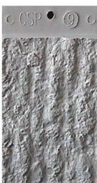
CSP-9: Silné frézování
