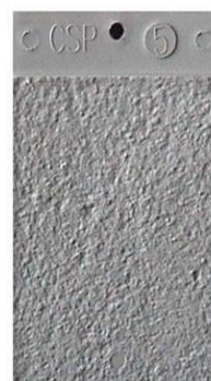
CSP-5: Středně brokované
