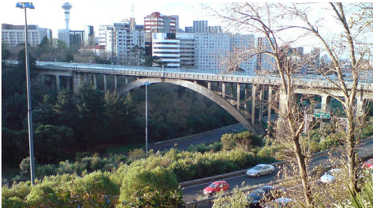
Grafton bridge, Auckland, Nový Zéland
