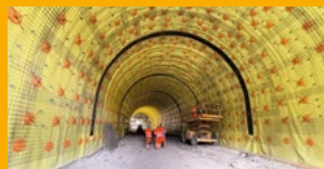
HYDROIZOLACE SPODNÍ STAVBY
