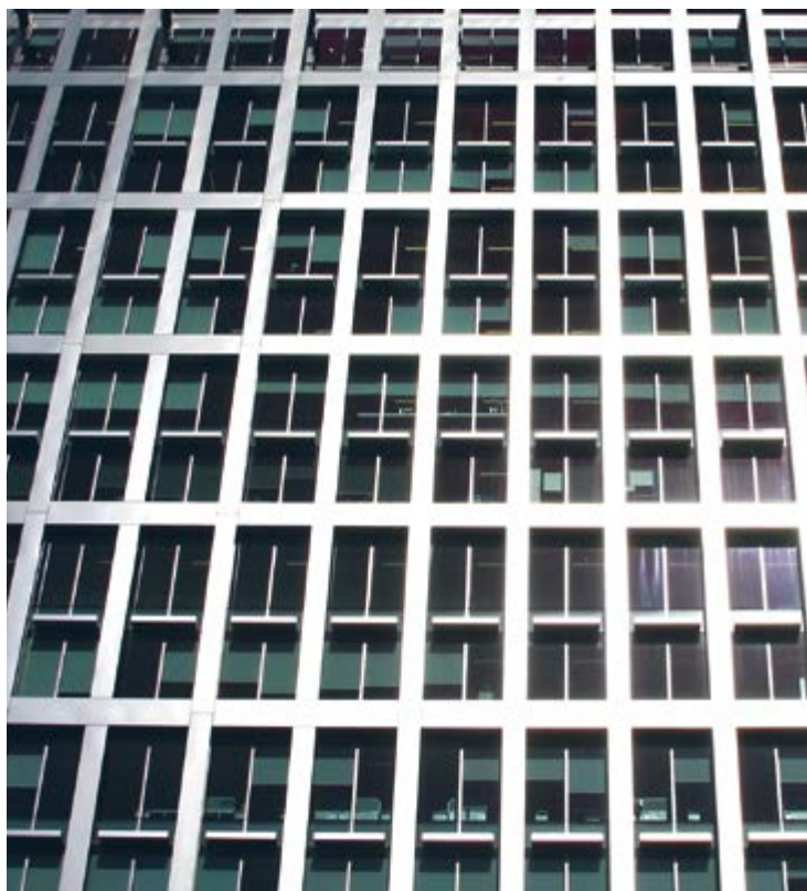
5 Aldermanbury Square, Londýn, 2005 Architekti Eric Parry Architects / Fasáda Lindner-Schmidlin UK
